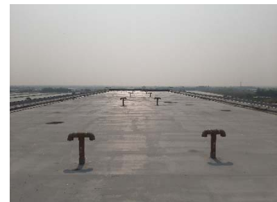
ท่อระบายอากาศบนอาคาร
