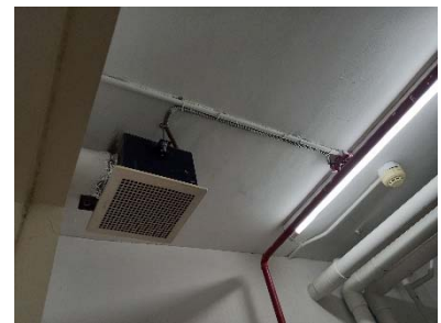
การระบายอากาศภายในห้องพัก มูลฝอยประจำชั้น
